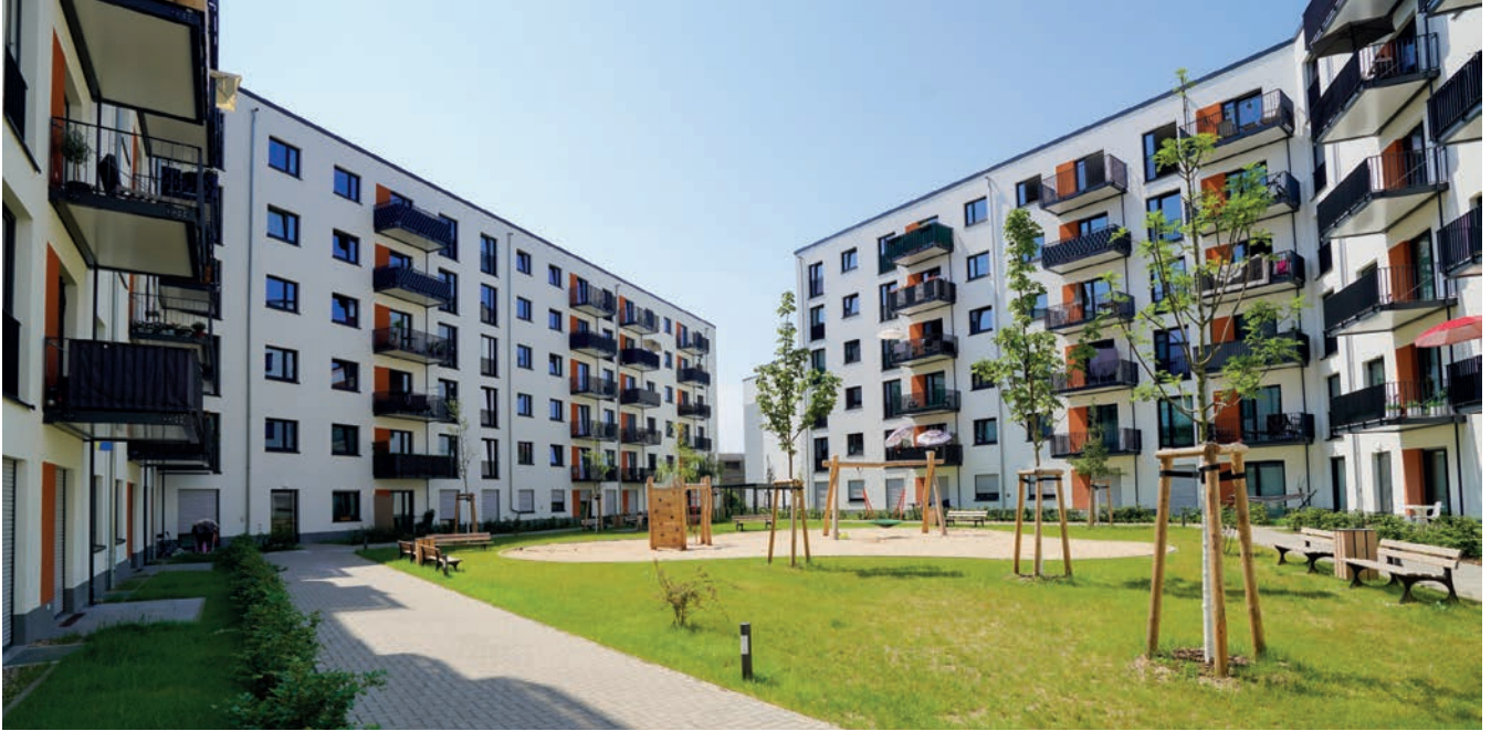
210 Wohnungen in elementierter Bauweise realisierte Goldbeck im Quartier Seehausener Straße.
